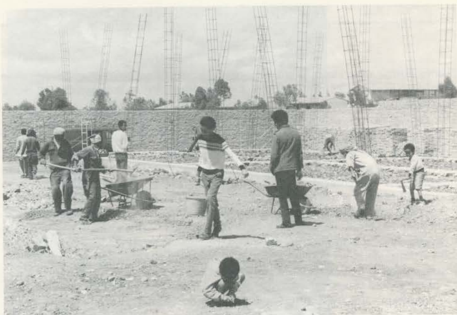
I lavori in corso al Centro di Carità di Asmara.
