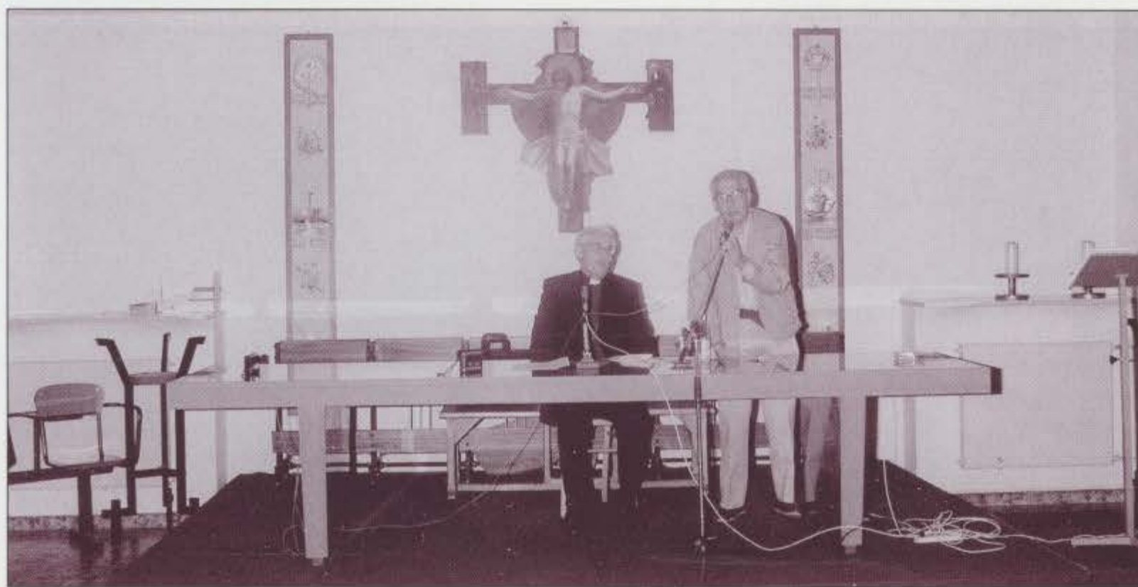
Intervento di V. Moccia al ritiro del 14 luglio.
