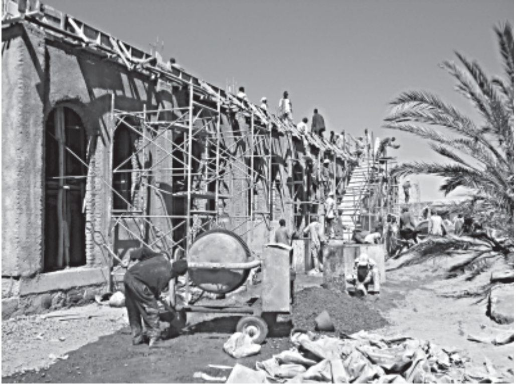
Asmara - L'inizio della costruzione del Centro di Carità
