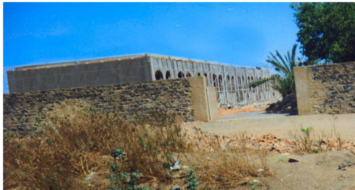
Piano terreno dell'edificio in costruzione
