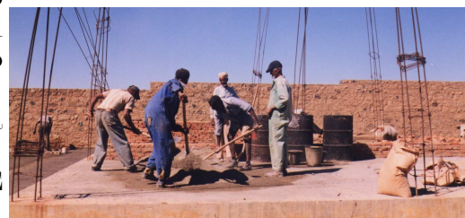
Operai al lavoro per l'edificio in costruzione
